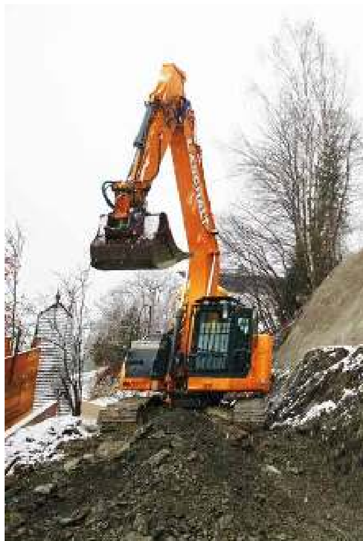
Baubeginn Zufahrt Herbst 2018
