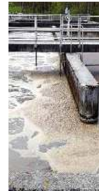
Blähschlamm Bildung durch Fett im Abwasser der Verbandskläranlage Bruck
