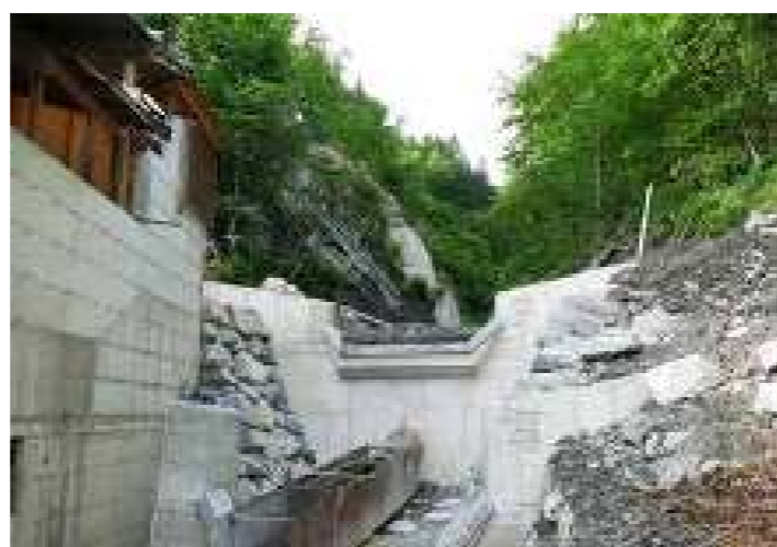
Neu errichtete Vorfeldsicherung
